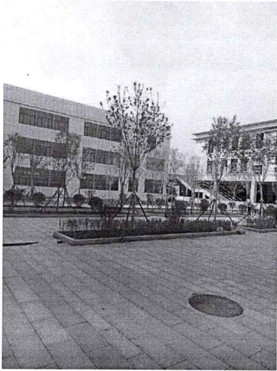
图一：多巴镇清源学校附属设施建设
