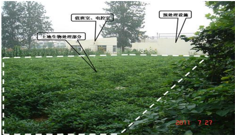
图 3-8 土地渗滤系统示意图
