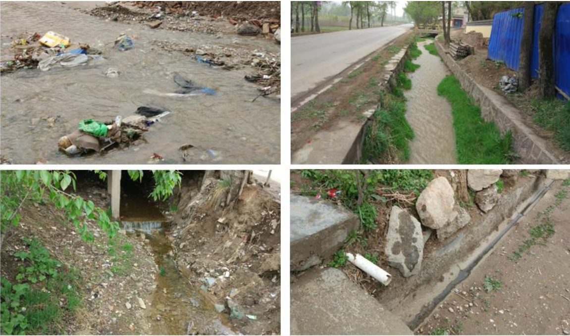
图 2-2 湟中农村生活污水现状
