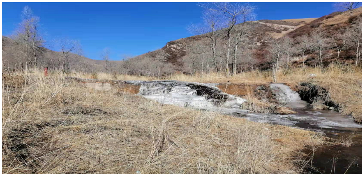
图片 1 泥麻隆村引水口现状
