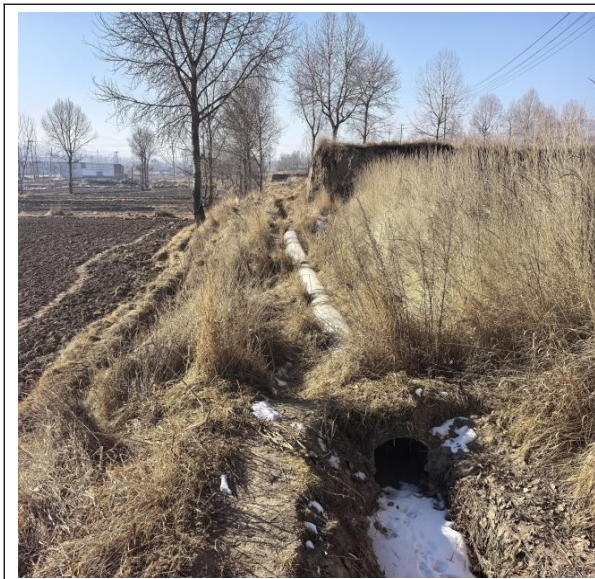
西堡灌区（马哈沟支渠临时波纹管）
