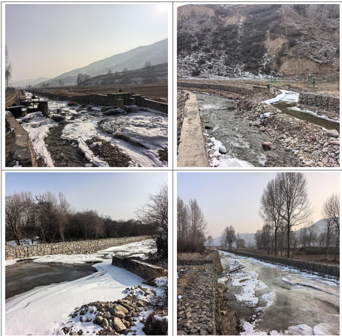
拦隆口灌区（西干渠渠道渗漏严重）
