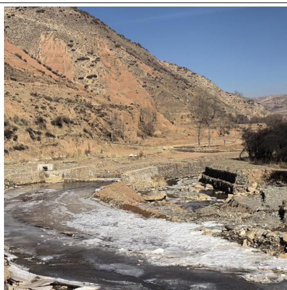
小南川灌区（引水口溢流堰冲毁）
