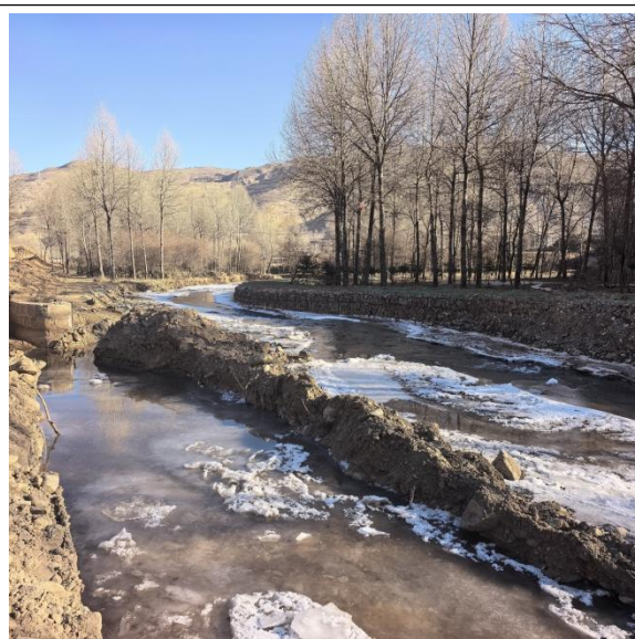
小南川灌区（引水口溢流堰冲毁）
