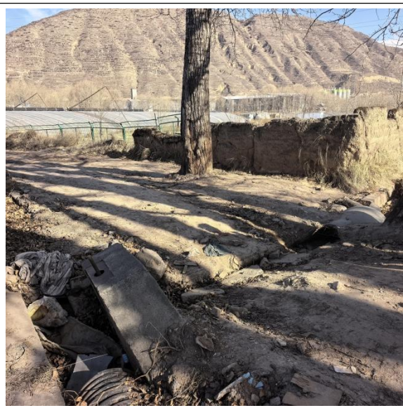
团结灌区（鲍家寨段渠道倒塌、分水口损坏）
