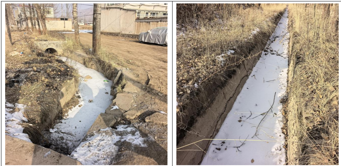
拦隆口灌区（西干渠渠道渗漏严重）
