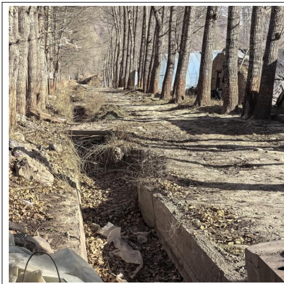
团结灌区（鲍家寨段渠道倒塌、分水口损坏）
