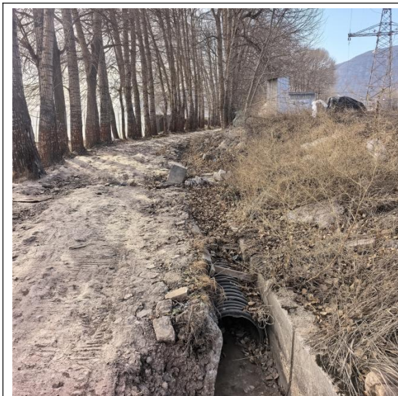
西堡灌区（东干渠寺尔寨段山体滑坡渠道掩埋）
