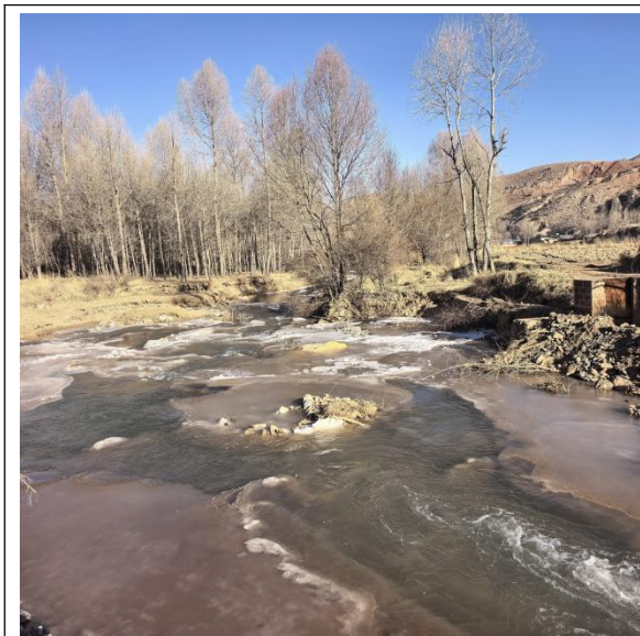
小南川灌区（引水口溢流堰冲毁）
