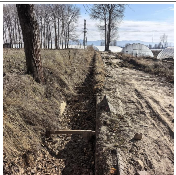
西堡灌区（东干渠寺尔寨段山体滑坡渠道掩埋）
