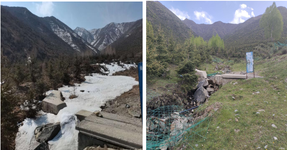
木场村（大天桥沟）已建水源情况
