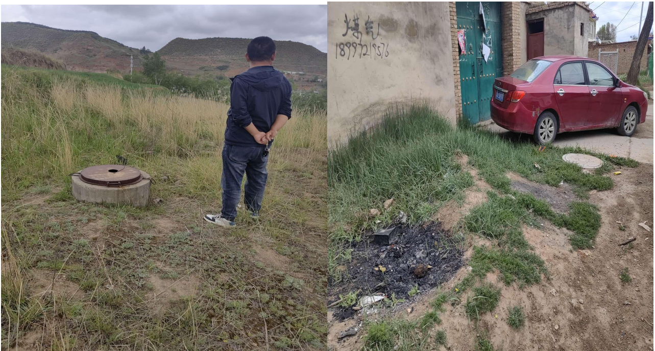
已建 200t 蓄水池运行良好
