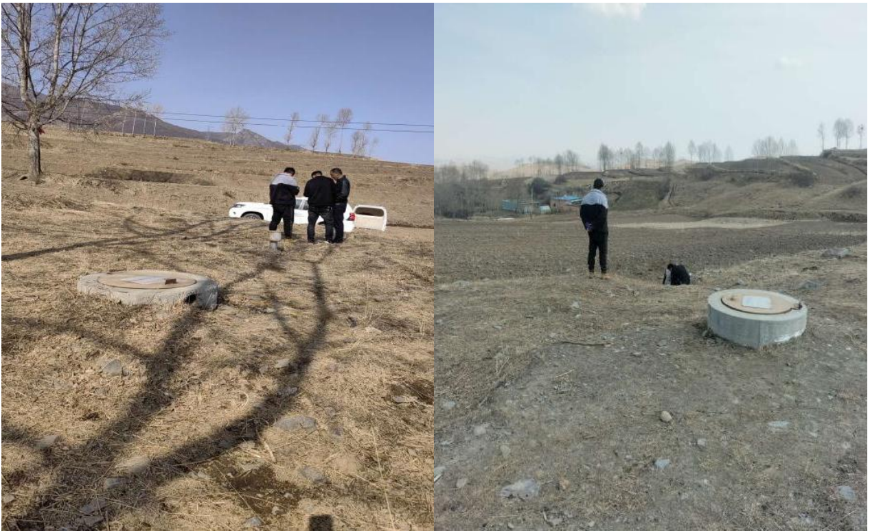
（3）阀门井工程：已建阀门井运行良好。
