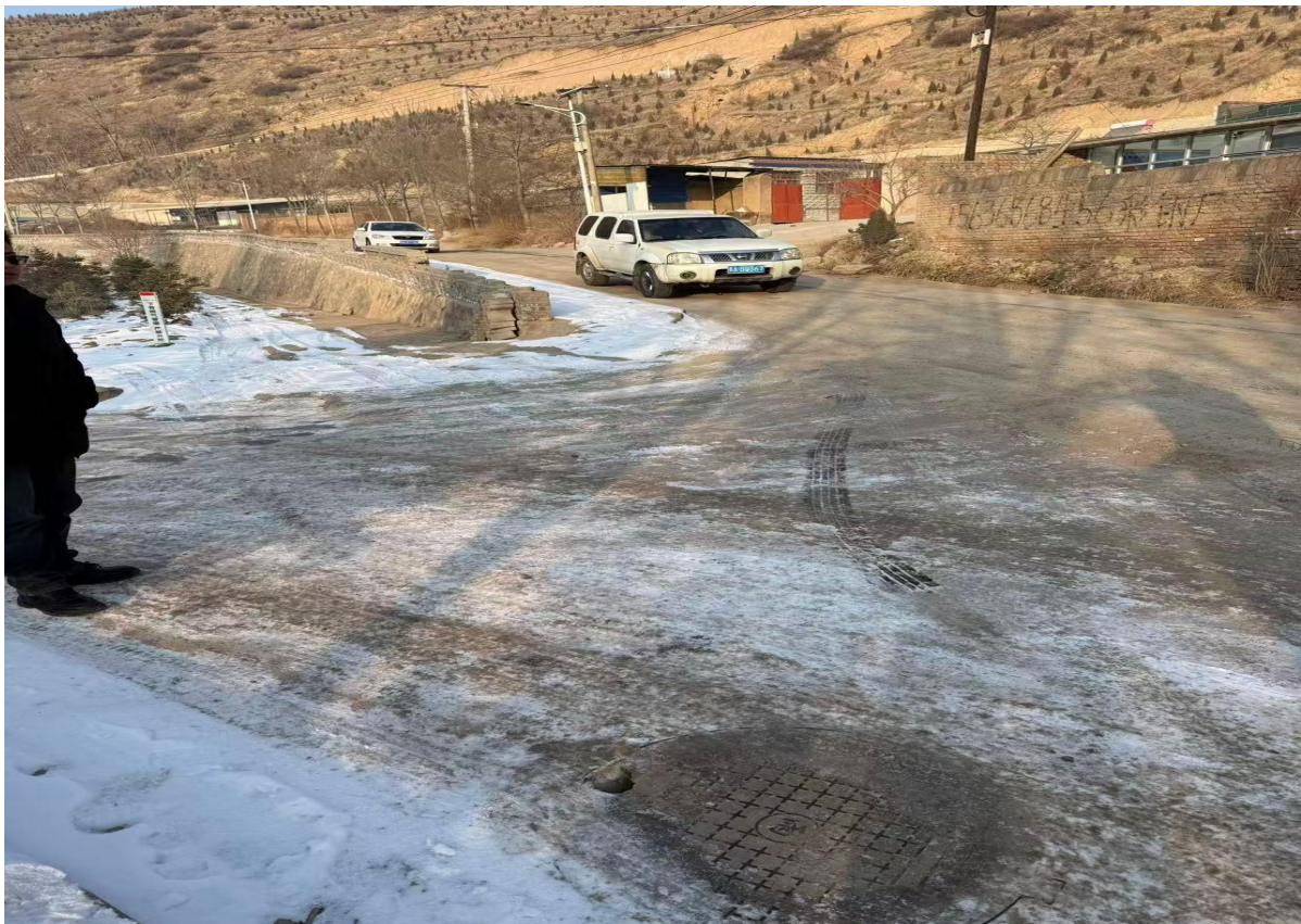
湟中区大才、汉东 27 村人畜饮水工程冰沟村供水管改线
