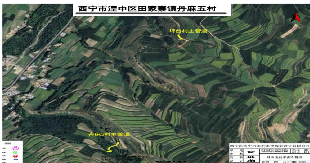
丹麻五村人饮管道地貌 图片 3-27-1
