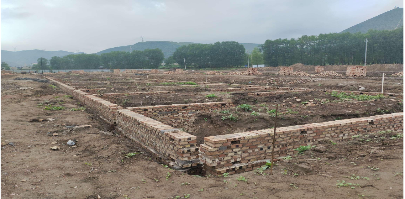
多巴镇安置点现状
