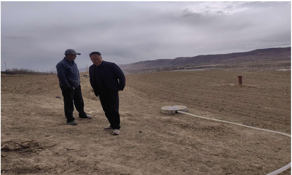
已建 200t 蓄水池目前运行良好
