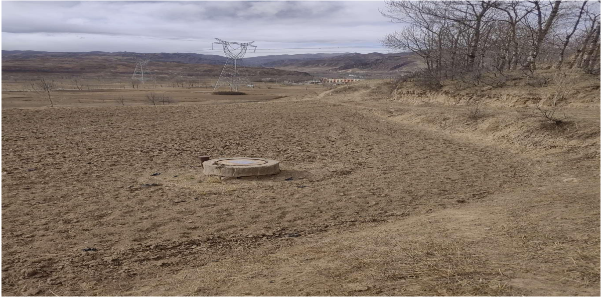
已建 100t 蓄水池目前运行良好
