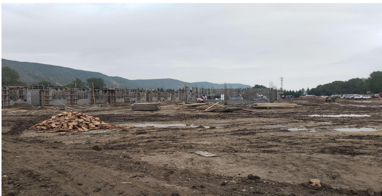
多巴镇安置点现状
