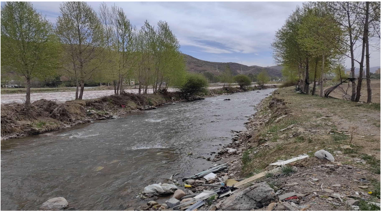
新建管线横穿西纳川河现状
