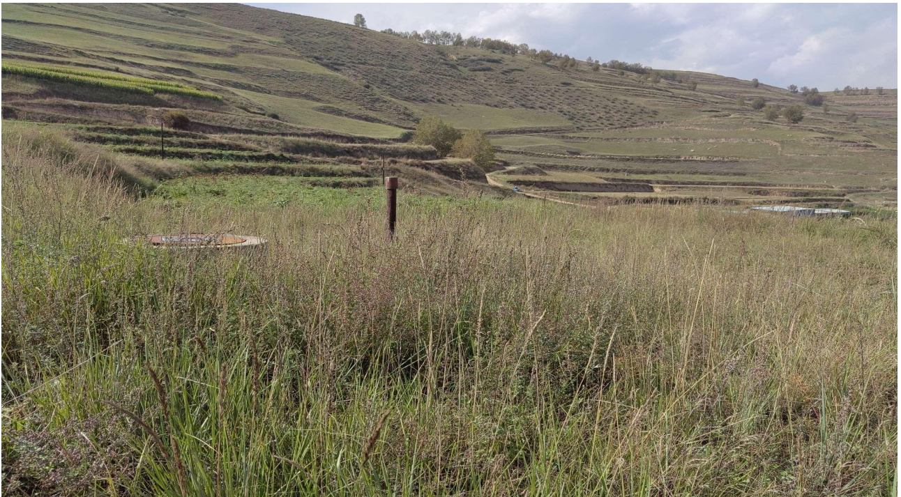
拦隆口村 100t 蓄水池
