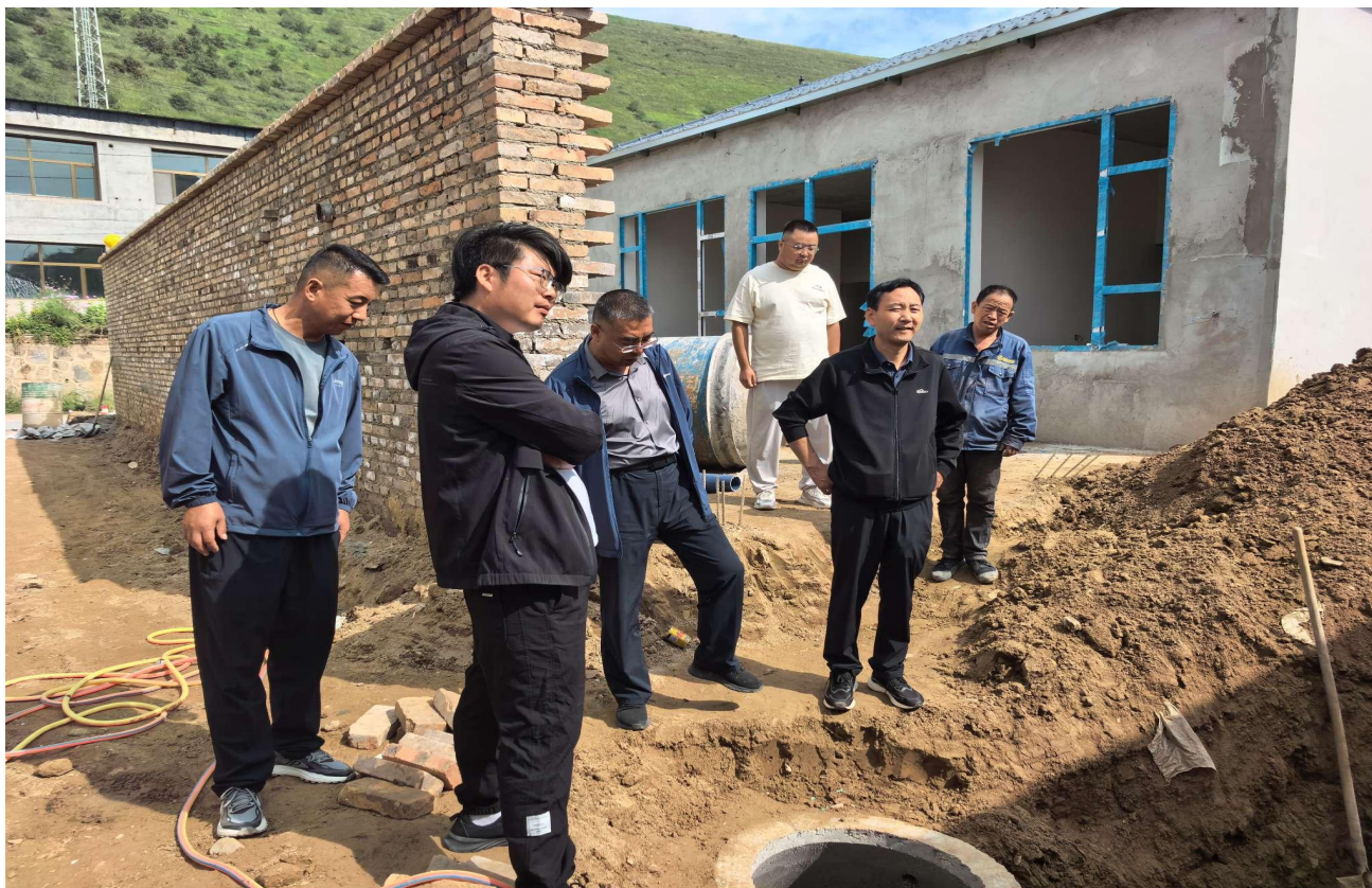
昂藏村二期安置点现状
