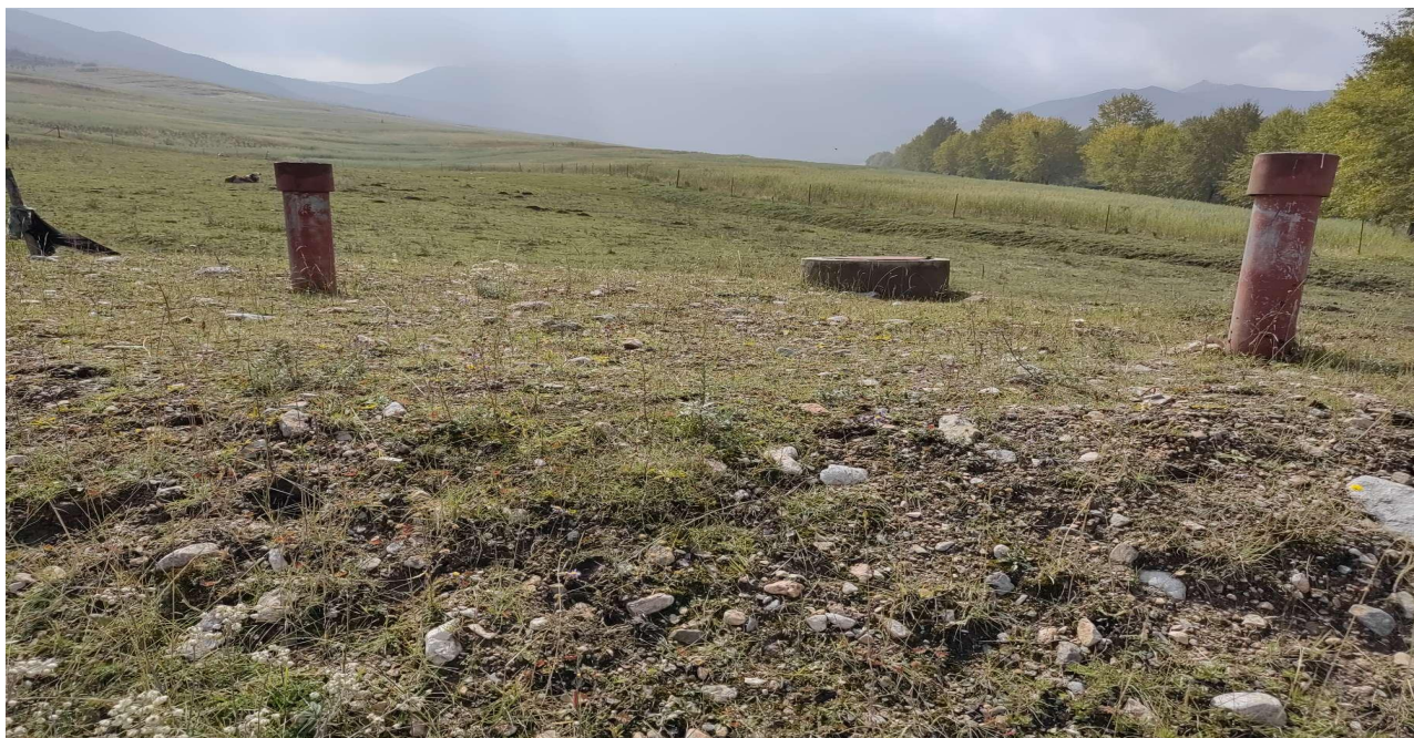
上台村阴坡已建 100t 蓄水池现状
