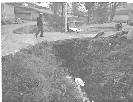
K0+000 排洪渠起点
