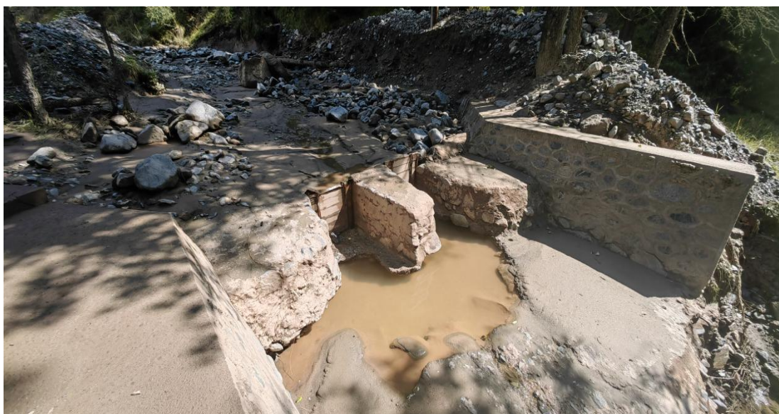
图 4.1-1 1#引水口冲刷损坏严重
