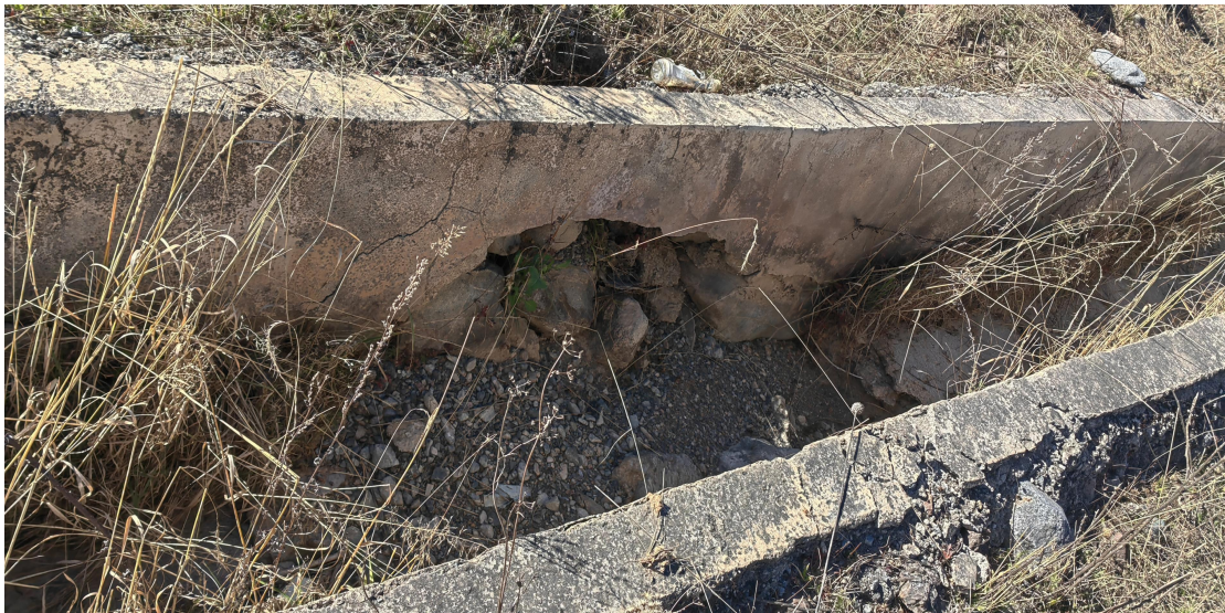
图 4.1-12 渠道边墙破损渗漏
