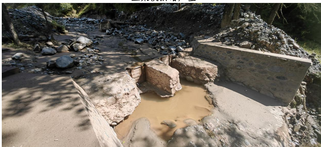
原有电站引水口冲砂闸处冲毁、淤堵严重
