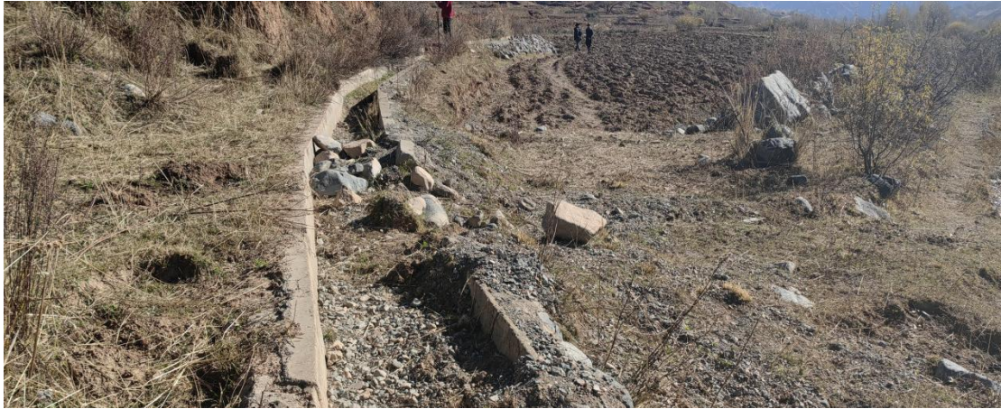
图 4.1-11 渠道边墙破损
