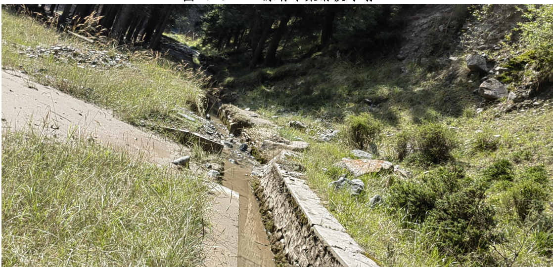
图4.1-4 干渠破损严重
