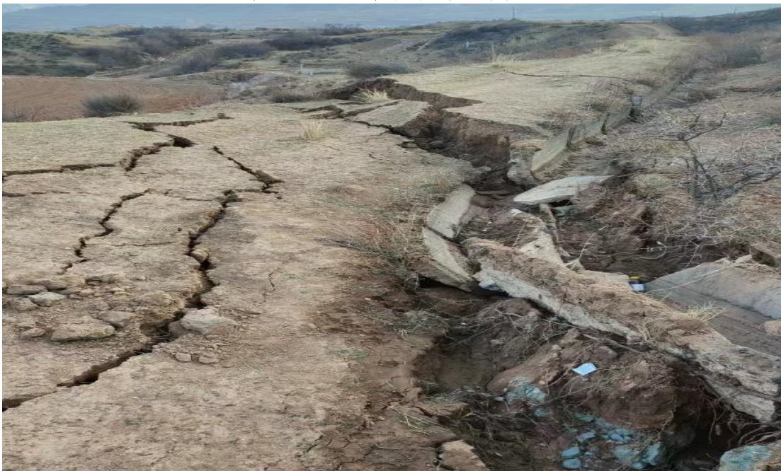
图 4.1-3 原有干渠滑坡垮塌
